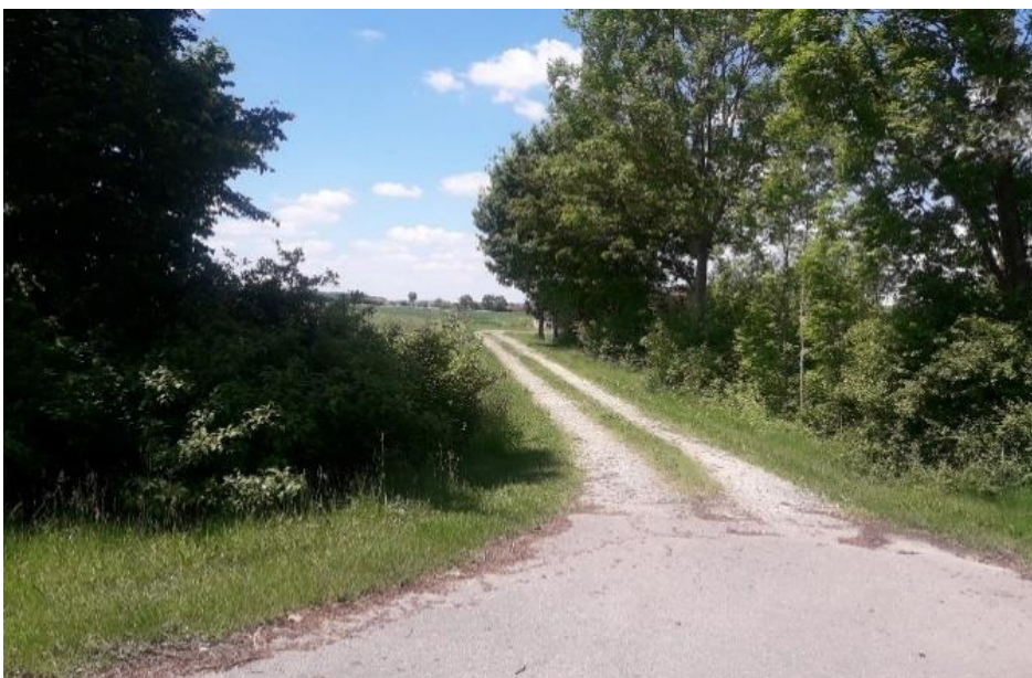
Abbildung 6: Blick auf ÖFK 63034 Richtung Westen (Begehung Scoping-Termin, Fachkräfte der Coplan AG, Juli 2020)
