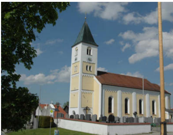
Denkmalgeschützte Saalkirche in Münchsdorf
