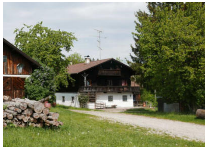
Historisches Gebäude im Außenbereich mit II+D
