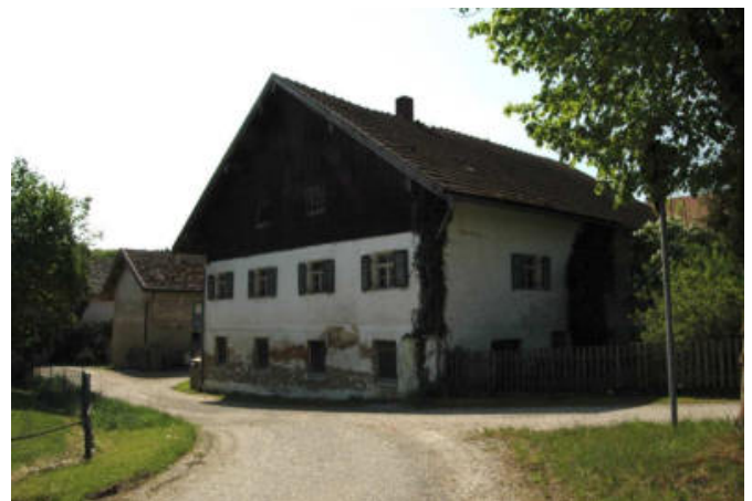
Historisches Gebäude im Außenbereich mit II+D
