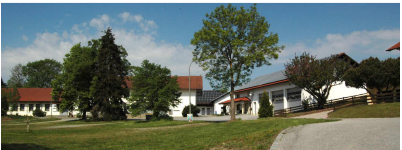
Großflächige Photovoltaikanlagen auf Dachflächen
