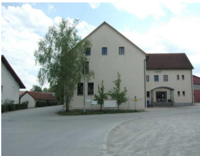
Grundschule in Roßbach
