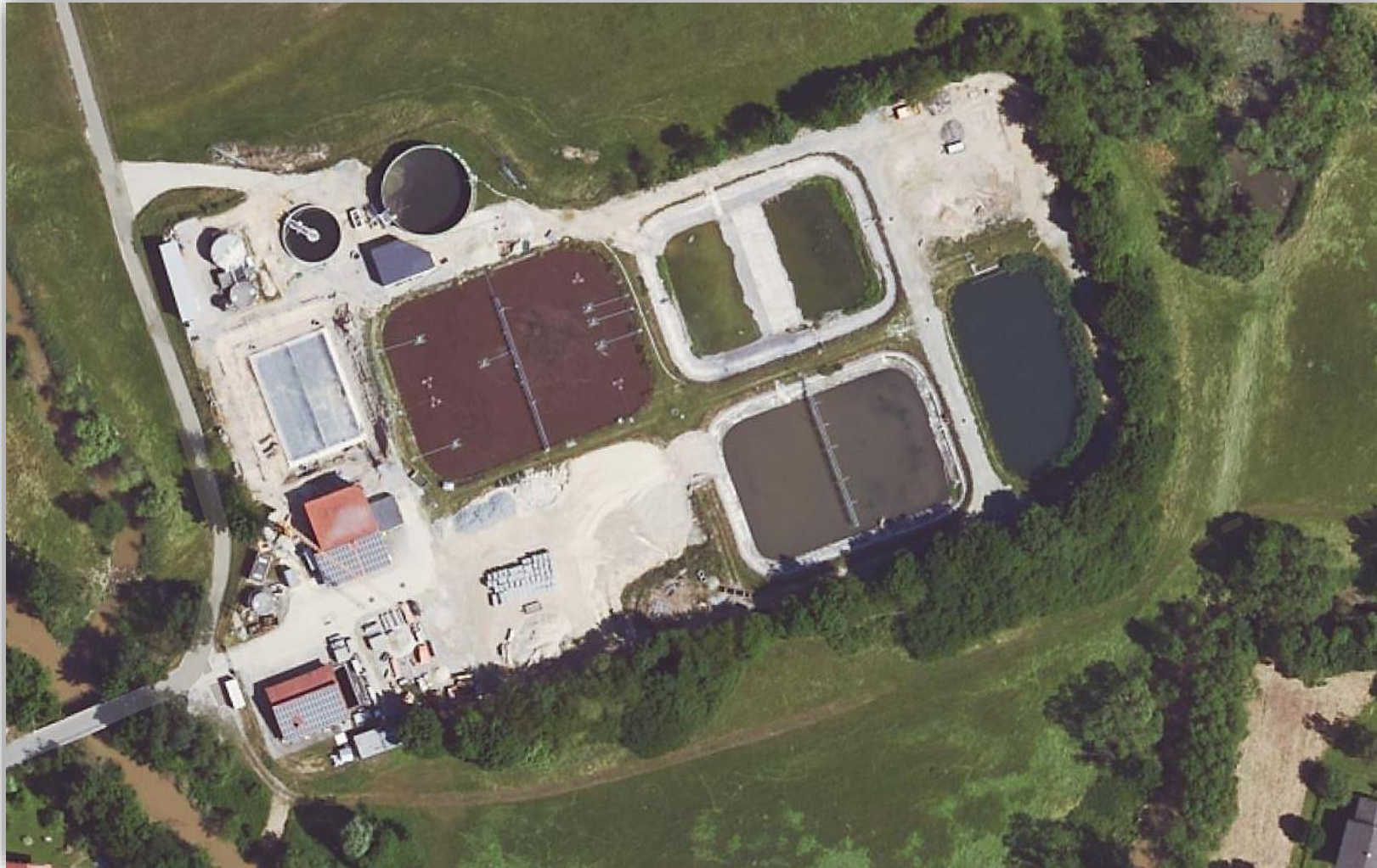
Während der Sanierung; Stand Dezember 2022
