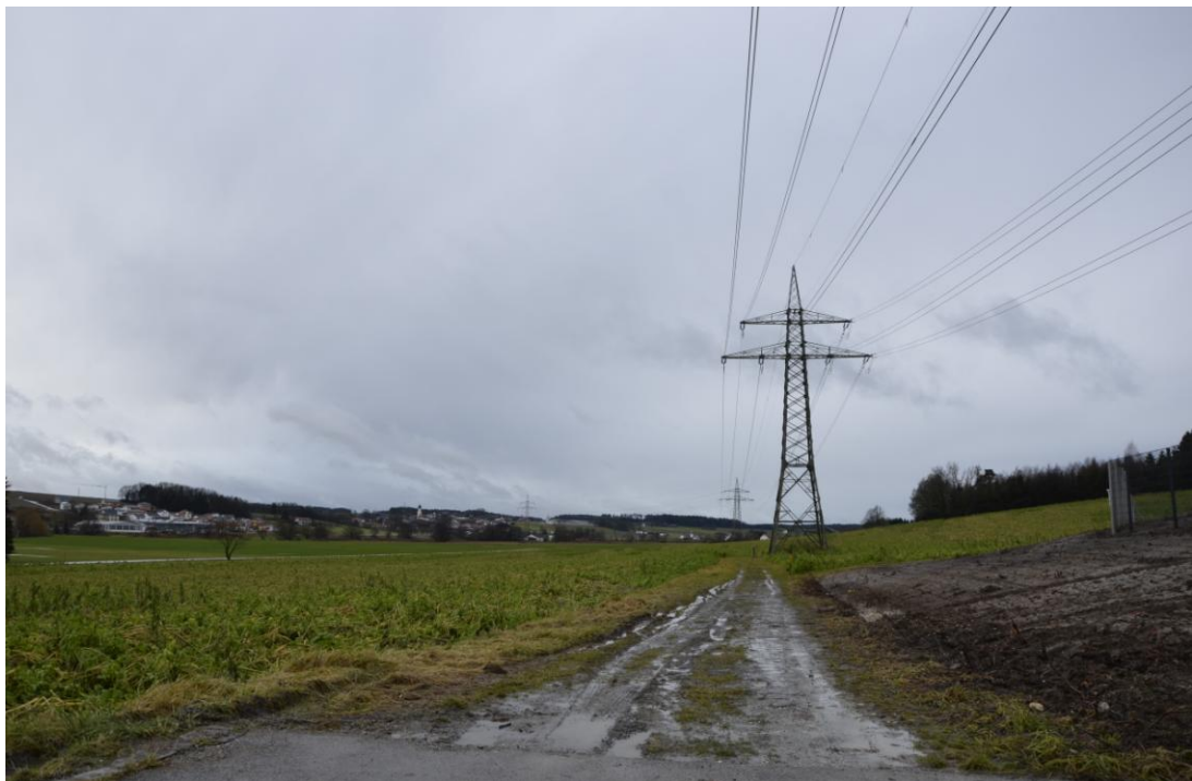
Abbildung 40: Foto in Blickrichtung Südwest - Einschränkung durch 110 KV-Leitung
