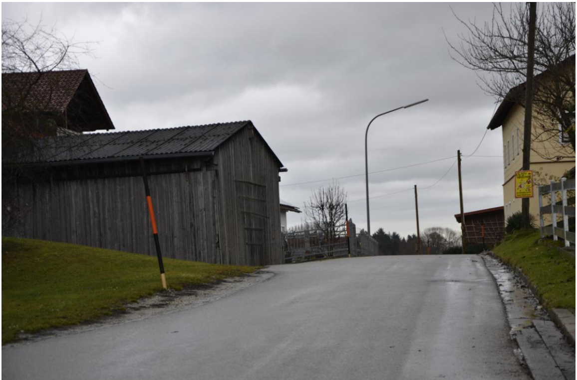
Abbildung 49: Ortsdurchfahrt Tabeckendorf - Engstelle, westliche der Fläche 12
