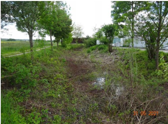
Abbildung 7: Blick auf ÖFK 63034 Richtung Westen (M. Karlstetter, Mai 2021)
