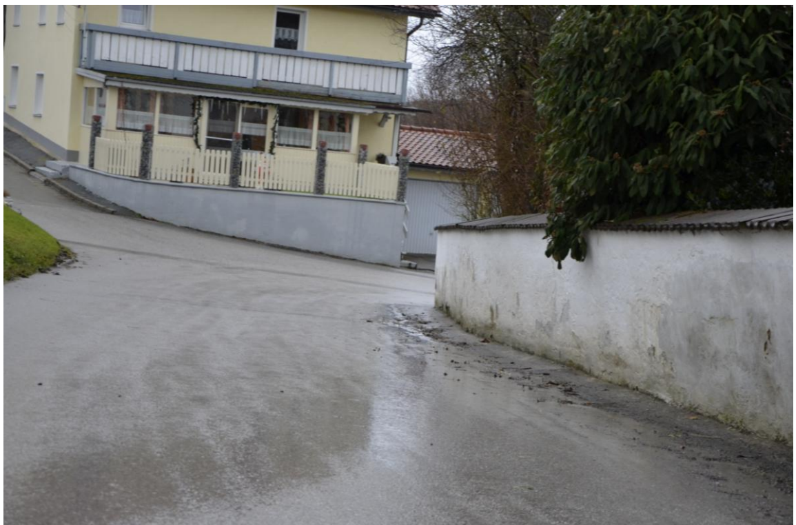
Abbildung 48: Ortsdurchfahrt Tabeckendorf, westliche der Fläche 12
